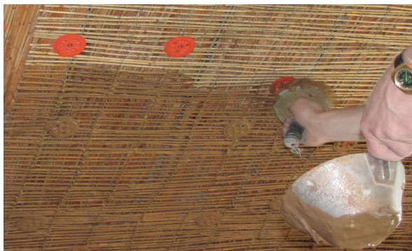
obr. 3 – nanášení přílnavostního nátěru
