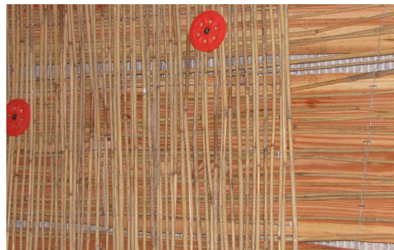
obr.2 – dvě vrstvy rákosu na prkenném záklopu
